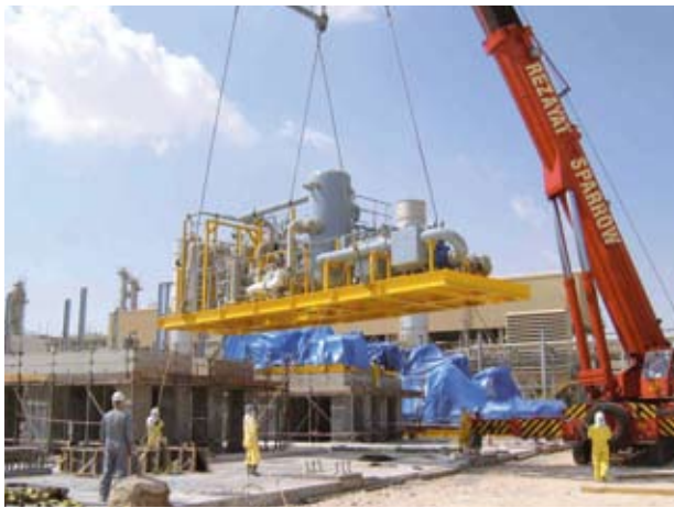
Sur le site de Ras Laffan, en novembre 2004, l'installation d'un skid de déshuilage de la station de compression hélium. Longueur : 15 m, largeur : 4 m, hauteur : 5,5 m.
